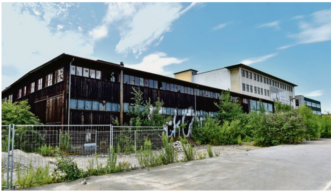
Der Abbruch der einstigen Fabrik ist nun rechtskräftig. Trotzdem fahren die Bagger nicht sofort auf.
