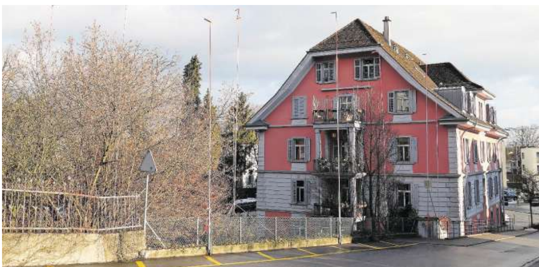
Die Bauprofile neben dem Roth-Haus zeigen, wo der Anbau stehen soll. Bild: Eddy Schambron
