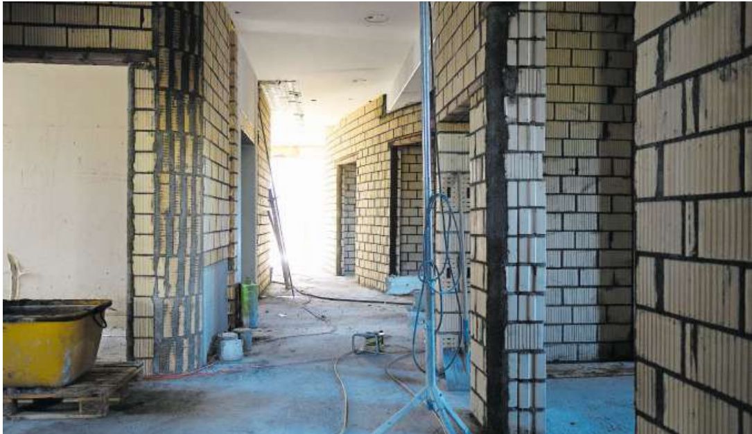
Im bestehenden Roth-Haus werden jetzt Einzelzimmer eingebaut.
